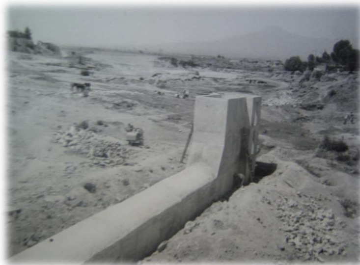
Imagen 7. Dique Niño Artillero del Vaso Regulador Diagonal Defensores de la Republica.
