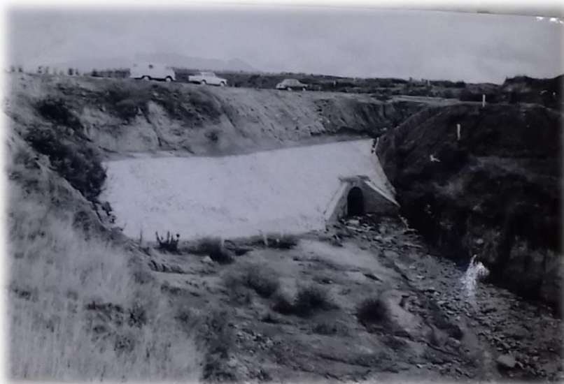
Imagen 6. Zampeado aguas debajo de la autopista sobre la Barranca Santuario.
