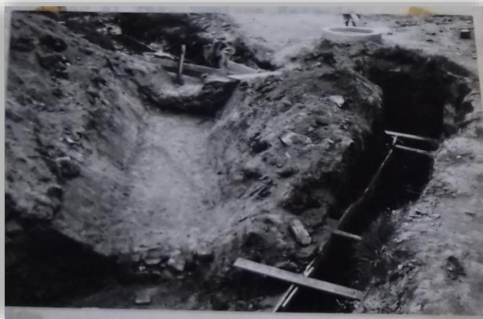
Imagen 8. Excavación para el desarenador provisional que recibe el caudal de la barranca Xalpatlac para conducirlo a otra sección.
